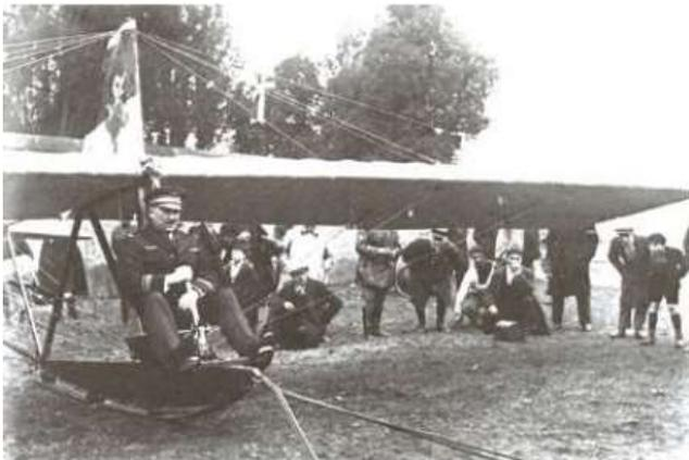
Le commandant Lucien GIRIER, en tenue officielle de sortie de l'Armée de l'Air aux commandes de «Crâne de Piaf» décoré pour l'occasion de rubans tricolores. Les deux sandows de lancement sont tendus par une équipe à l'avant de l'appareil, retenu à l'arrière par une autre équipe.
